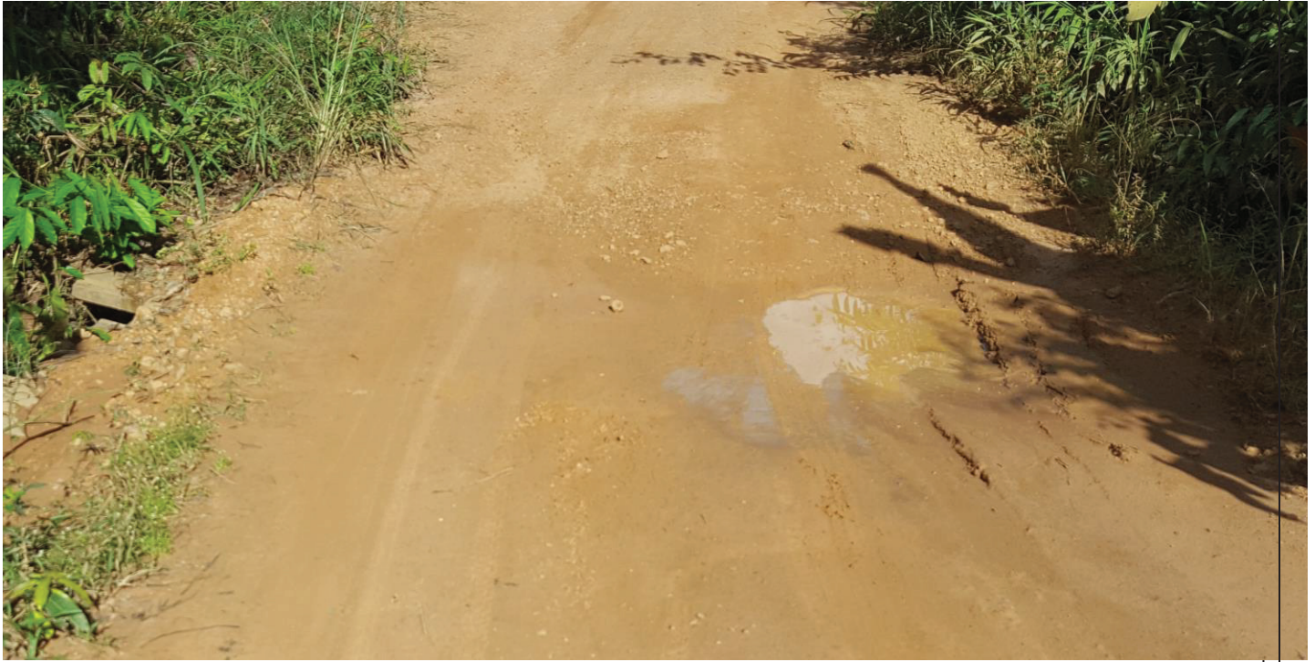
Foto 1 – BDTC para executar (Ø 1,20 m). Trecho N° 2-3 - Coordenadas UTM: 8756729.49 m S e 718375.55 m E
