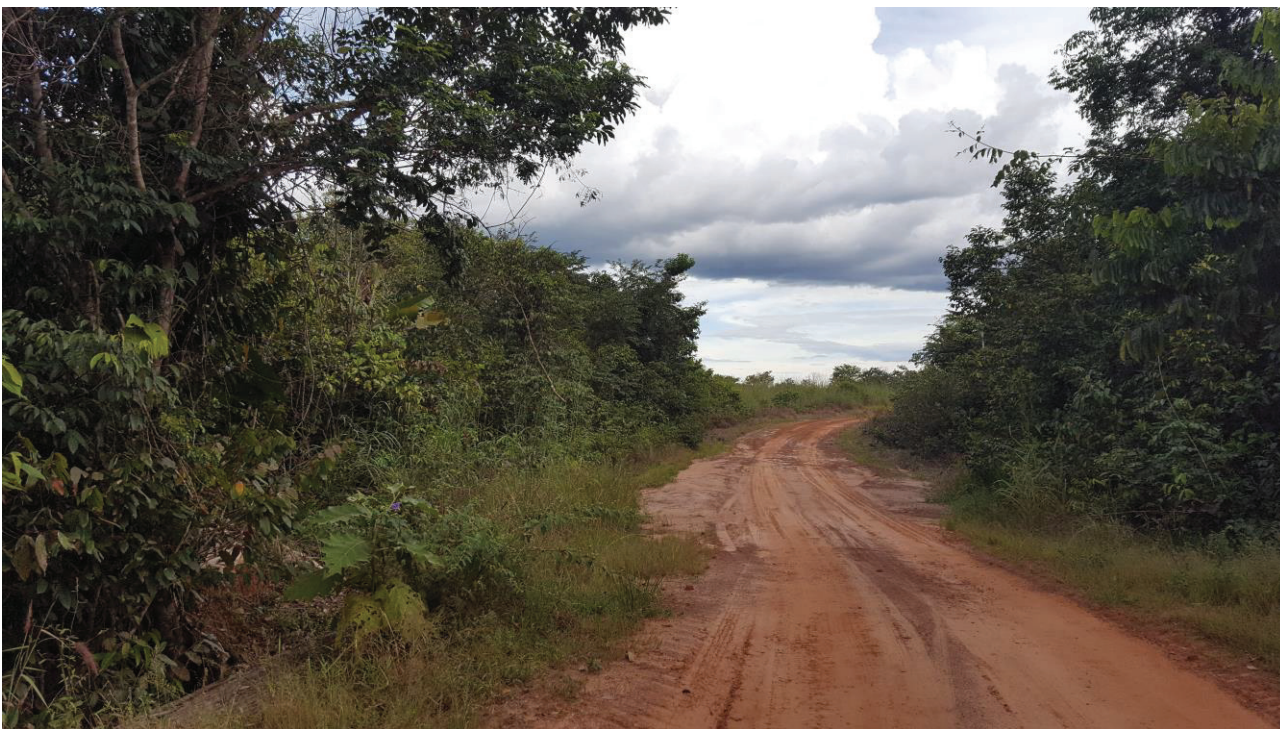
Foto 6 – Pontilhão aterrado existente. Trecho N° 10-11 - Coordenadas UTM: 8751705.29 m S e 708274.24 m E
