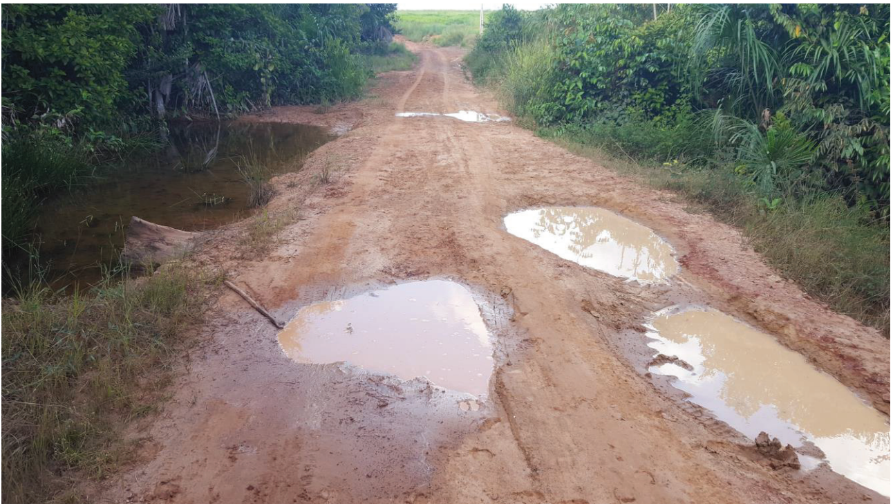
Foto 2 – BDTC para executar (Ø 1,20 m). Trecho N° 2-3 - Coordenadas UTM: 8758701.89 m S e 713583.76 m E
