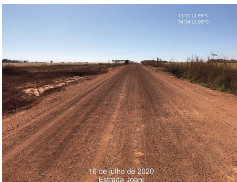
Foto 2: Drenagem inadequada
