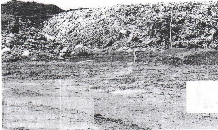
Figura 05 – Detalhe da mangueira do sistema de recirculação do chorume sob o maciço de resíduos.
