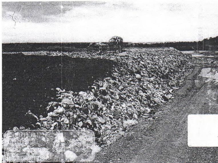
Figura 02 – Frente de trabalho, com máquina esteira fazendo a compactação, espalhamento e cobertura dos resíduos.
