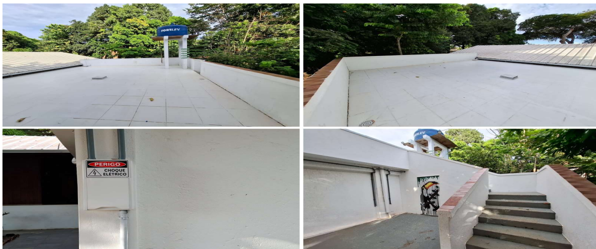
Imagens 10 — Laje de cobertura com caixa d'água, acesso por escada e quadro de distribuição elétrica sinalizado.
