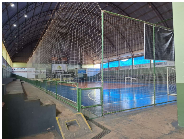
Foto 14 — quadra coberta mais recente, com piso e redes de proteção em boas condições.
