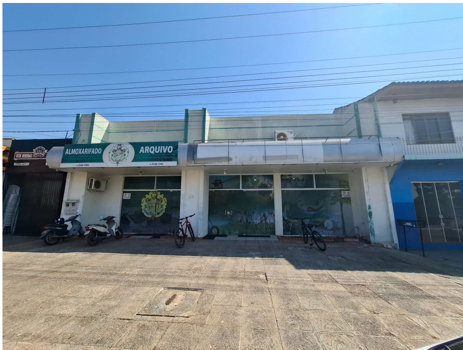
Foto 1 — fachada do imóvel alugado onde funcionam o Almoxarifado Municipal e o Arquivo Municipal.
