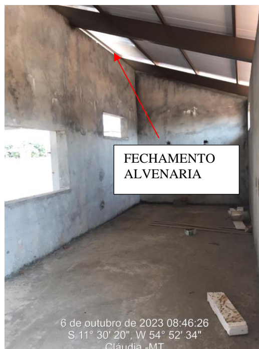
Figura 13: Fechamento alvenaria da lanchonete
