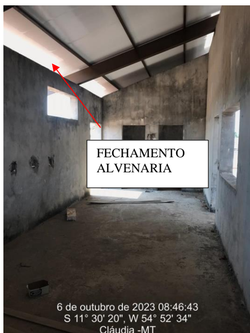
Figura 14: Fechamento alvenaria da lanchonete.
